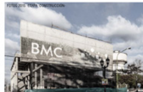
FOTOS 2015 -ETAPA CONSTRUCCIÓN-
