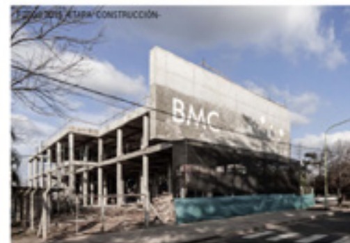
FOTOS 2015 -ETAPA CONSTRUCCIÓN-
